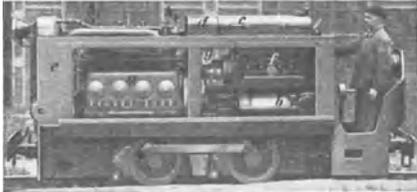
Abb. 584. Außenansicht einer Schweröl-Lokomotive mit abgenommenen Seitenblechen.
