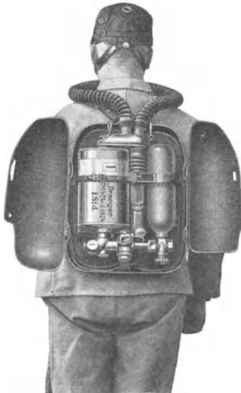
Abb. 858. Ansicht des Dräger-Klein-Gasschutzgerätes.
