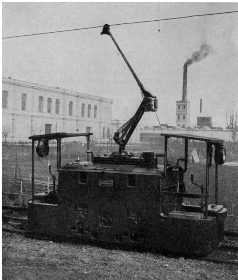
Abb. 386. Rollenstromabnehmer für große Höhenunterschiede der Fahrleitung (SSW).
