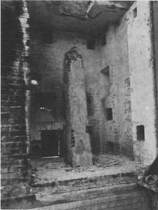
Bild 16. Pfeiler aus Mauerziegeln 1. Klasse in Kalkzementmörtel (geputzt)
