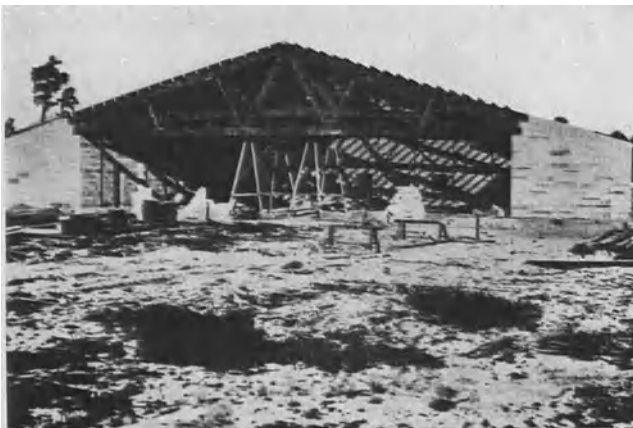
Bild 5. Halle aus Leichtkalksandsteinen
