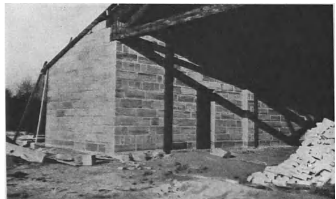
Bild 6. Ecke der Halle
