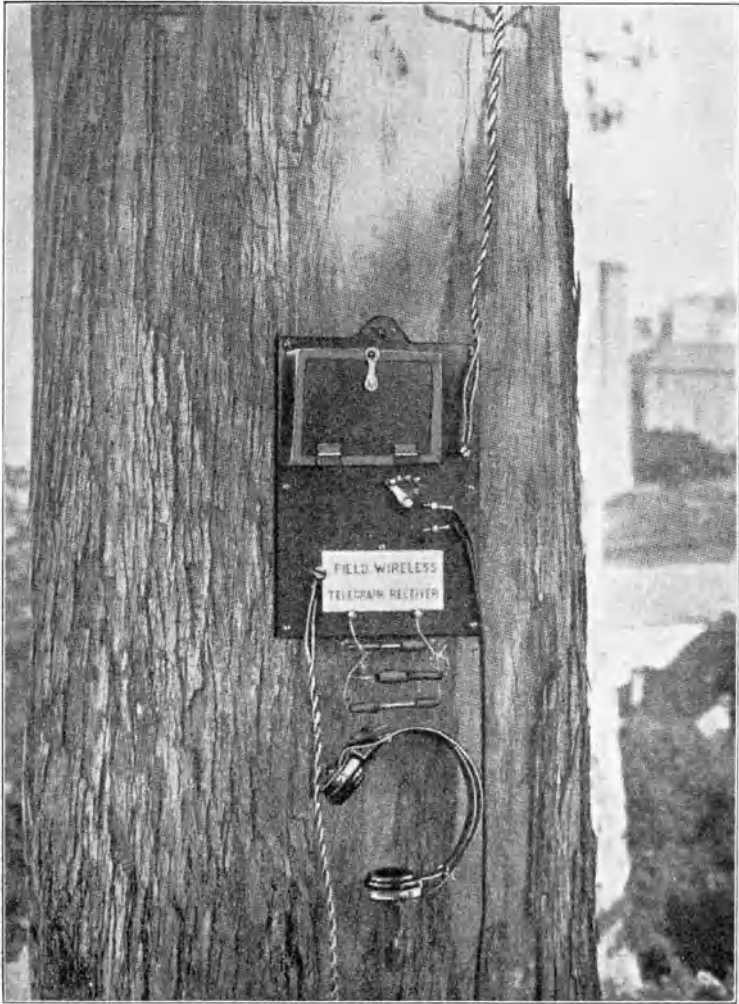
Figur 29. Empfangsapparat nach Major Squier.
