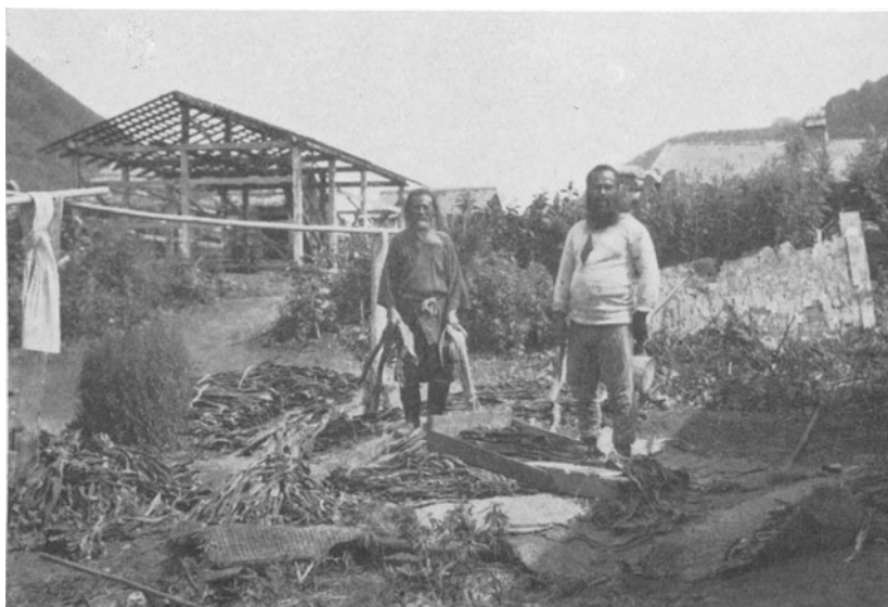
Abb. 112. Ainu in Tarandomari auf Sachalin trocknen und sortieren die Meeresalge Laminaria , die in Japan allgemein gegessen wird.
