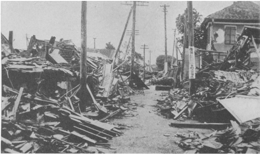
Abb. 70. Straße von Nago bei Hojo nach dem Erdbeben
