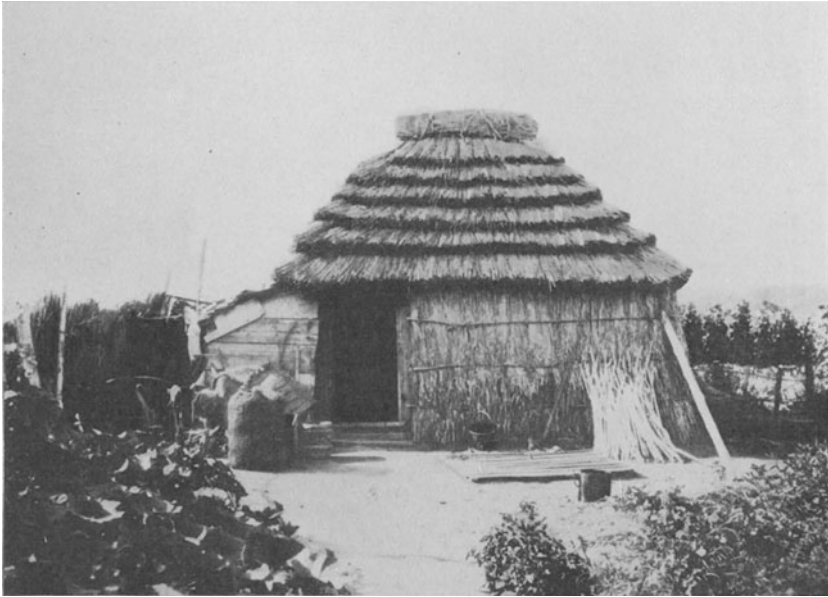
Abb. 98. Ainuhütte bei Schiraoi, von oben bis unten mit Stroh von Miscanthus gedeckt
