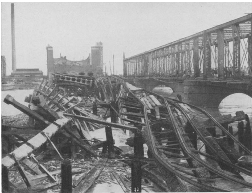
Abb. 68. Azuma-Brücke in Tokio nach dem Erdbeben
