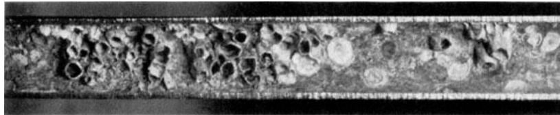
Abb. 3. Verstopfung von Rohren durch Muschelgehäuse. V=0,8
