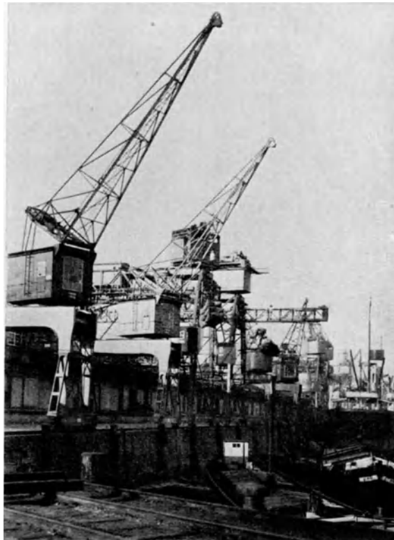
Abb. 31. Moderne Wippkräne (Typ Kampnagel) im Hamburger Hafen.
