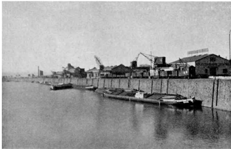
Abb. 19. Östlicher Teil des Nordkais des Albert-Hafens.
