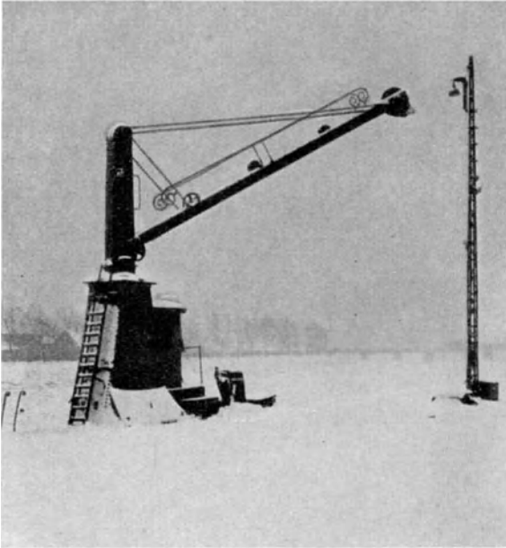
Abb. 29. Hydraulischer Uferdrehkran am fiskalischen Umschlagplatz in Magdeburg.
