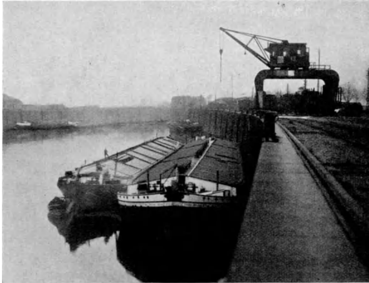
Abb. 18. Der feste 5 t Vollportalkran am Nordkai des Albert-Hafens.
