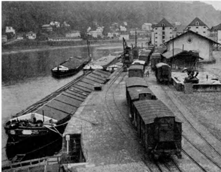
Abb. 13. Tetschen: Kaistrecke B unterhalb der Straßenbrücke, siehe Abb. 12.
