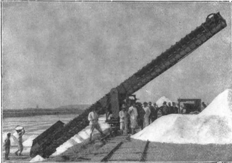
Abb. 153. Fahrbarer Gurtförderer zur Gewinnung von Meersalz, bestehend aus einem Segeltuchgurt mit Ketteneinfassung, von Stotz. Achsenabstand 12 m.
