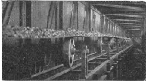
Abb. 156. Stahlband für Kohleförderung (Sandviken).
