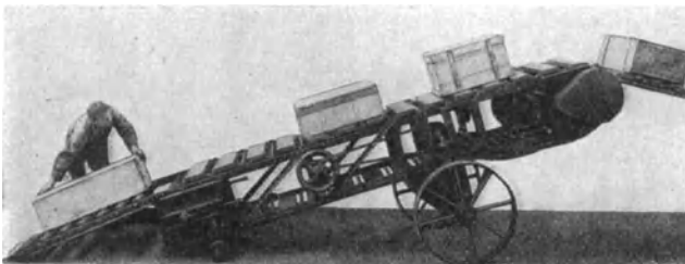
Abb. 232. Fahrbares Gliederband zur Beladung und Entladung von Eisenbahnwagen (Stöhr).
