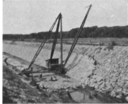
Abb. 224. Skogaby, Abpflasterung des Unterkanals, Blick stromabwärts. (NWK.)
