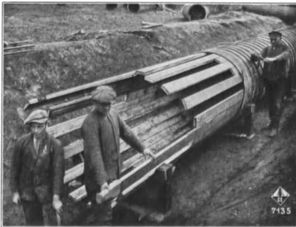
Abb. 347. Turbinenleitung Mylau. Vorstrecken des kontinuierlichen Holzrohres, offen verlegt auf Holzsätteln mit Betonfundamenten. d = 1215 mm, Gesamtlänge 284 m. Druck am unteren Ende 9 m W.S. (Steinbeis u. Kohns., Rosenheim.)
