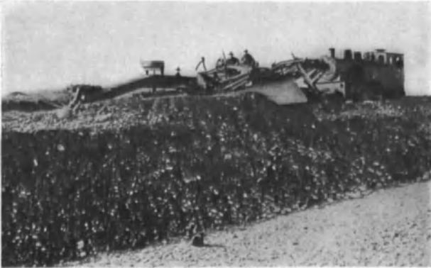
Abb. 233. Planierpflug (Kippenräumer) beim Kanaldambau Kembs. (Verw.)
