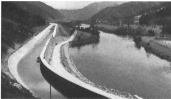
Abb. 222a. Hangkanal des Murkraftwerkes Mixnitz.
