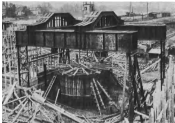
Abb. 485. Blechträger zur Aufnahme der senkrechten Lasten von Generator und Turbine (Kraftwerk Griesheim a. M.).
