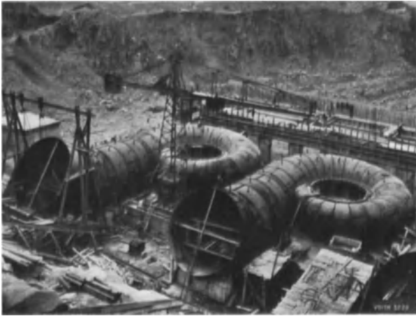
Abb. 488. Spiralgehäuse aus Stahlblech, Shannon-Werk (J. M. Voith, Heidenheim).
