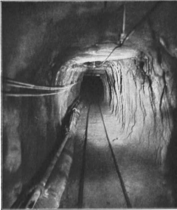
Abb. 260. Stollen mit Torkretauskleidung des Heimbachkraftwerkes in Württemberg. (Siemens Bauunion.)
