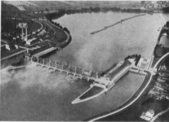
Abb. 500. Gesamtansicht des Doppelwerkes Augst-Wyhlen. (Schweiz. Bauztg.)
