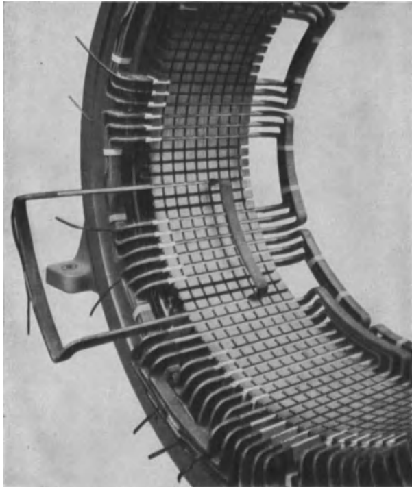
Abb. 597. Anker eines Wechselstromerzeugers bei der Montage. (Brown, Boveri & Cie.)
