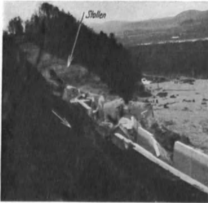
Abb. 222. Kanalbruch Alzwerk Hirten-Holzfelden.
