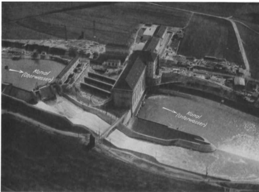
Abb. 554. Kraftwerk III der Mittleren Isar bei Eitting. Wasserschloß mit Überfall, Leerlauf und Schußrinne. Werkseinlaß, Druckrohrleitung, Kraft- und Schalthaus (Verw.).
