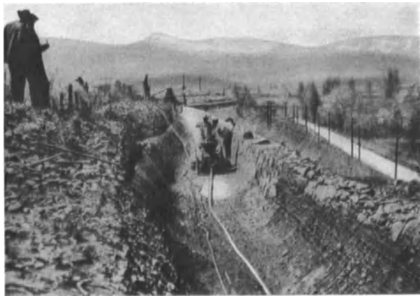
Abb. 240. Hangstrecke eines Bewässerungskanals in Calif. (Cement Gun Co., Allentown USA.) Rechts Trockenmauer. Bewehrung zum Torkretieren ist eingebracht.
