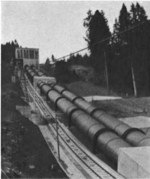
Abb. 299. Schluchsee, Fallrohrleitung des Kraftwerks Häusern (Ludin).
