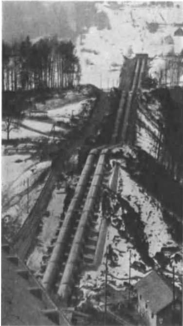
Abb. 297. Fallrohrleitung des Wäggitalwerkes (untere Stufe, Siebnen).
