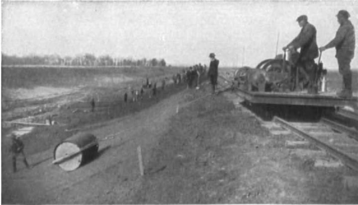
Abb. 219. Einwalzen einer plastischen Böschungsdichtung mit in der Falllinie geführten Walzen.
