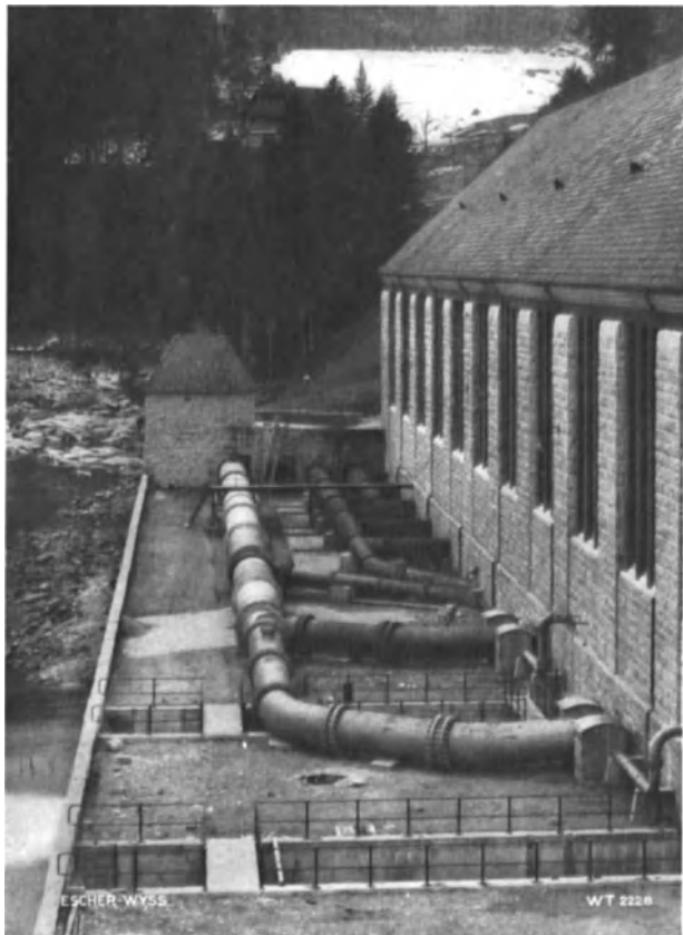
Abb. 312. Murg-Schwarzenbachwerk. Verteilrohrleitungen der Ober- (links) und Unterstufe (rechts). (Escher Wyss & Co., Ravensburg.)
