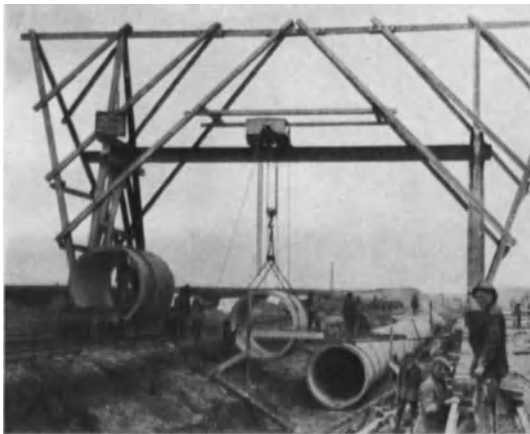
Abb. 329. Verlegung der 2 m weiten Schleuderrohre der Mittl. Isar A. G. (Züblin-Vianini).
