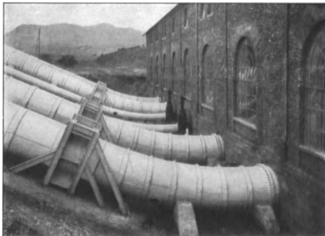
Abb. 310. Ventavon. Verankerung der Fallrohrleitung vor dem Krafthaus (Ludin).
