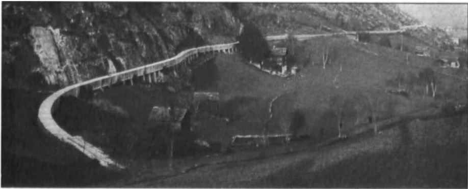
Abb. 247. Eisenbeton-Hangkanal Mörel-Brieg. Blick talaufwärts (Ludin).
