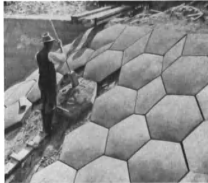
Abb. 228. Abdeckung der Böschung mit Sechseckplatten.
