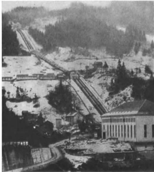
Abb. 298. Fallrohrleitung der oberen Stufe des Wäggitalwerkes (Rempen).
