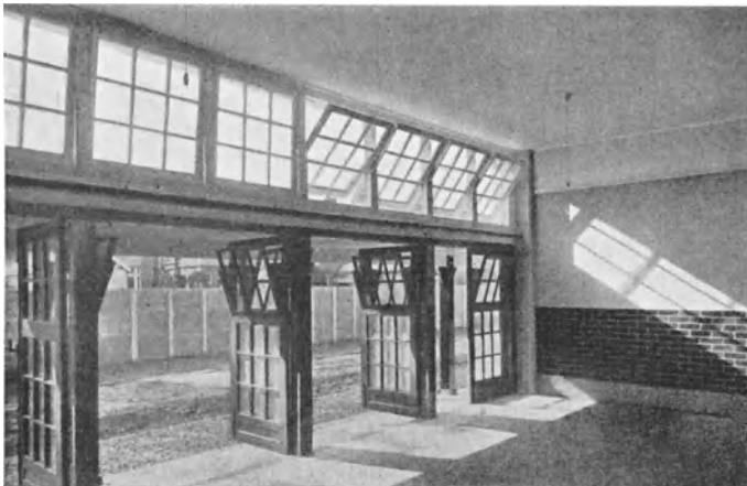
Abb. 4. Blick aus dem Klassenraum auf die geöffnete südliche Fensterwand und „Veranda“, darüber aufklappbare Sonnenfenster.
