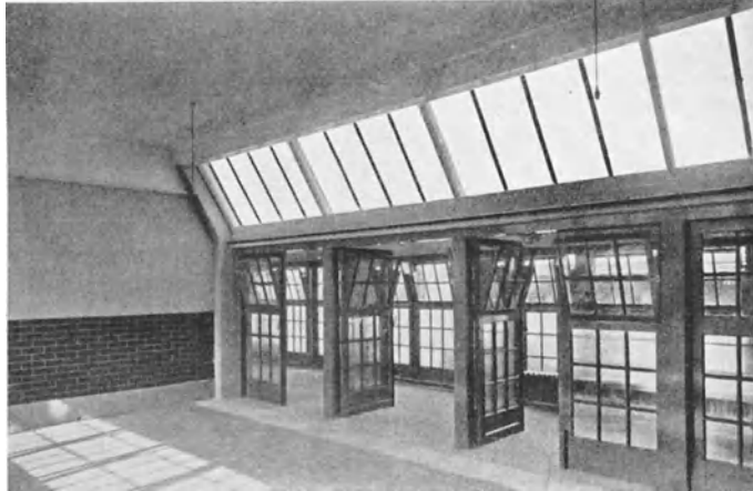
Abb. 3. Blick aus dem Klassenraum auf den Korridor der Nordseite und die nordseitigen schrägen Oberlichtfenster.
