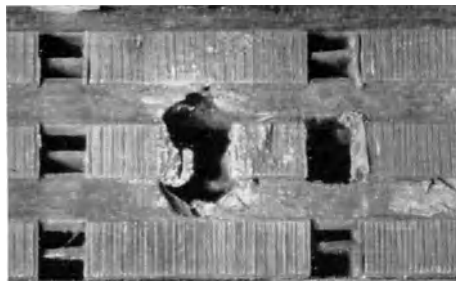
Abb. 14. Ausbrennungen durch Eisenschluß im Läufer eines Gleichstromgenerators, 900 kW.
