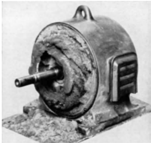
Abb. 7. Mit Holzmehl ganz verstopfter Motor aus einer Möbelfabrik.
