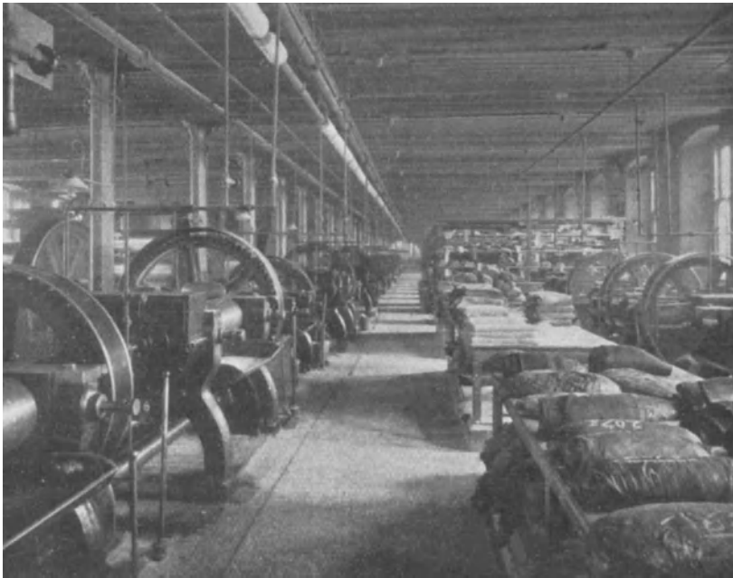
Abb. 31. Strang von Mischwalzen; auf den Tischen Puppen gemischten Kautschuks.
