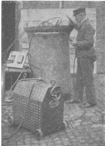
Abb. 184. Schweißen von Rissen an Glühtöpfen.
