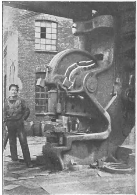
Abb. 197. Schweißung des Balanziers einer Schiffbaustanze.
