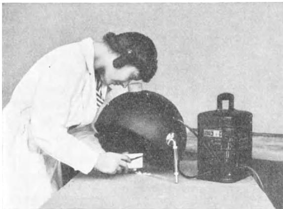
Abb. 15. Aufteilung des Chromatogramms unter der tragbaren Quarzlampe.
