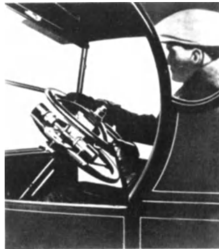
Abb. 594. Gerät zur Aufnahme der am Lenkrad wirkenden Momente (251).
