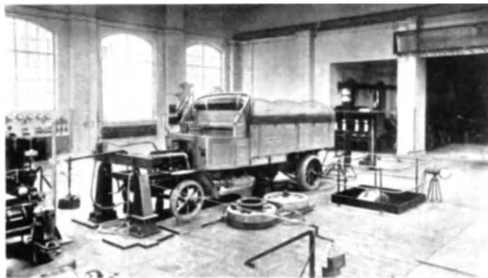
Abb. 441. Aufstellung eines Fahrzeuges auf dem Prüfstand. [Nach Riedler (343).]
