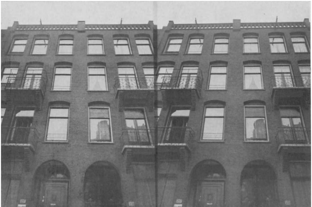
Abb. 112. Stereoskopische Aufnahme eines Gebäudes, wobei die Platte nicht parallel gestellt ist. Zu betrachten mit Weitwinkellupen von 8 cm Brennweite unter einem Winkel von etwa 45^\circ nach oben.
