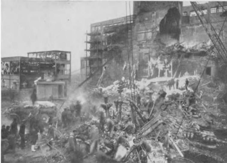
Abb. 4. Zerstörungen nach einer Dextrinstaubexplosion.
