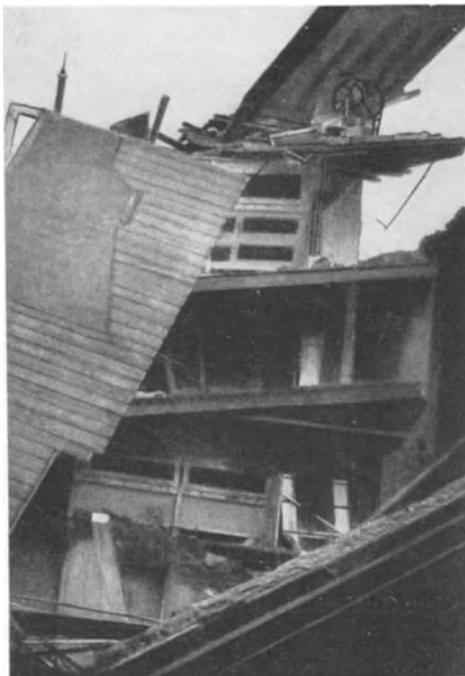
Abb. 13. Staubexplosion in einer Zuckermühle.
