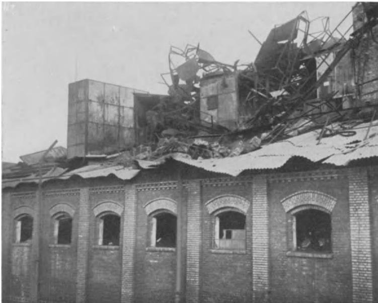
Abb. 9. Abzugsschlote, in welchen Glimmnester entstanden. (Zu Bericht Nr 20, S. 26.)
