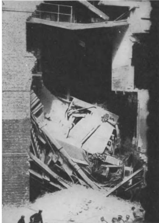
Abb. 1. Durch Staubexplosion zerstörte 800-mm-Mauern im Vorbrecherraum einer Raffinerie.
