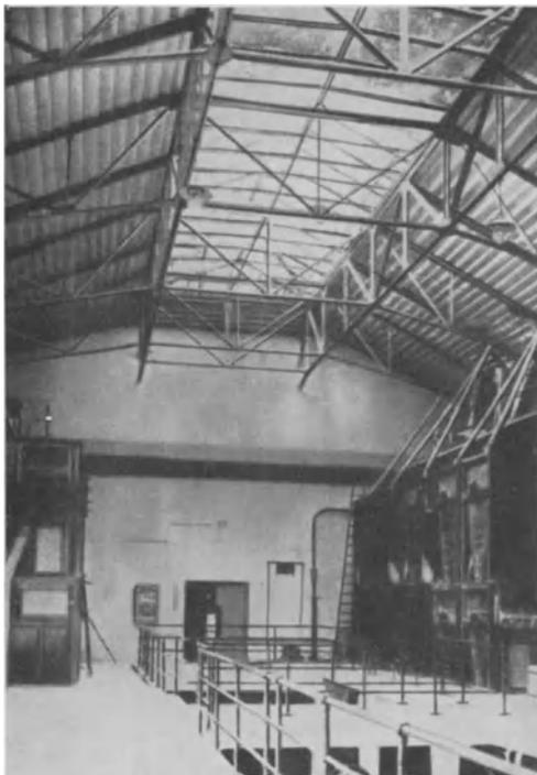
Abb. 2. Moderner Zuckermühlenbau nach Durchrasen einer Staubexplosions-Druckwelle. Außer zerstörten Oberlichtfenstern keine Beschädigungen.
