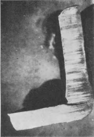
Abb. 118. Gebrochene, stumpfgeschweißte Wasserkammer.
