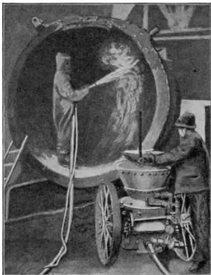
Fig. 33. Torkretierung einer Gießpfanne. (St. u. E. 1926, S. 13.)
