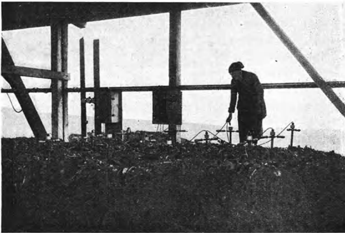
Abb. 25. Grubensilo mit 12 Elektropolen.
