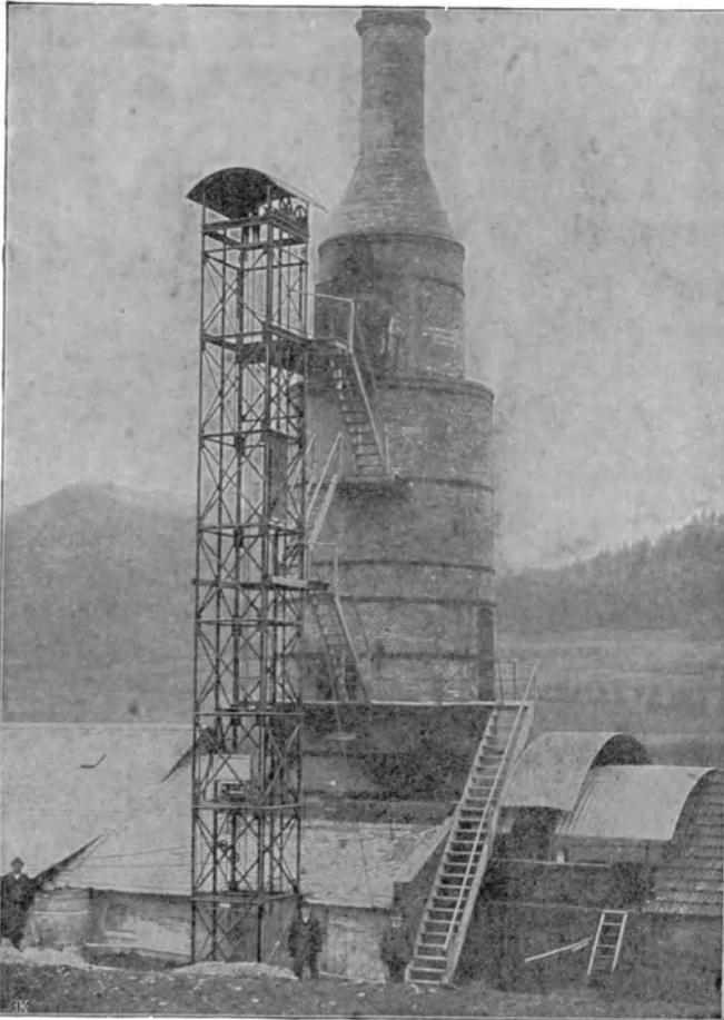
Fig. 72a. Schachtofen mit freistehendem Aufzug.
