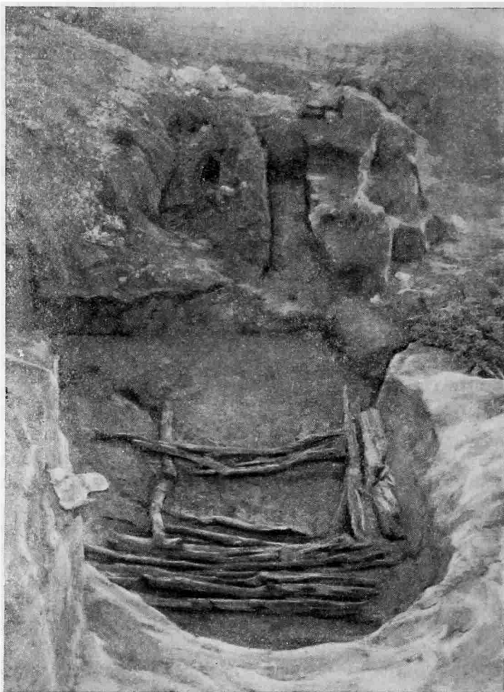
Рис. 14. Печь и котлован с водостоком перед печью
