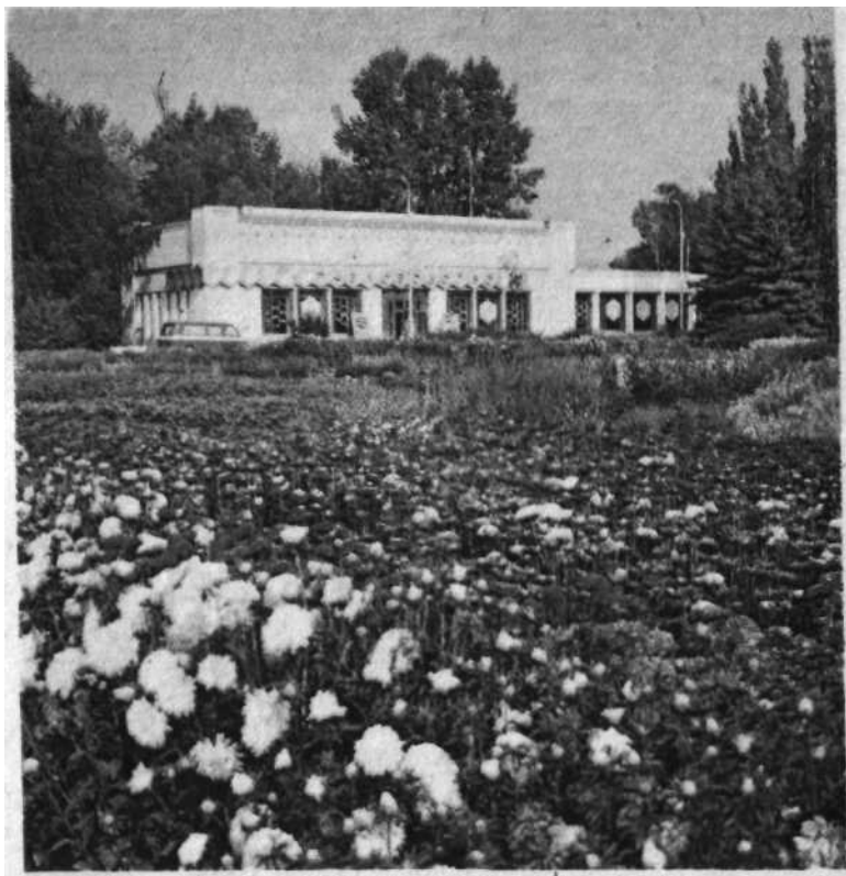
84. Павильон «Пчеловодство» на ВДНХ СССР — центр обмена передовым опытом пчеловодов.
