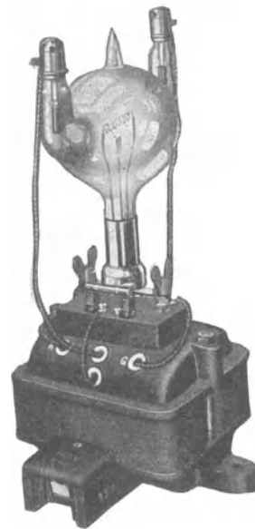
Bild 1. Wehnelt-Gleichrichter mit Oxydkathode und Argonfüllung.
