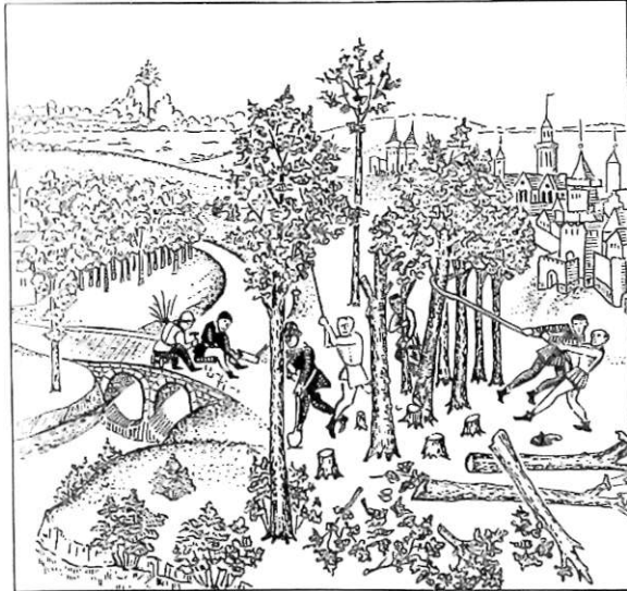
и Дорожные работы, починка моста. С миниатюры XV в. 15 Строительство каменного моста. С миниатюры XV в.
