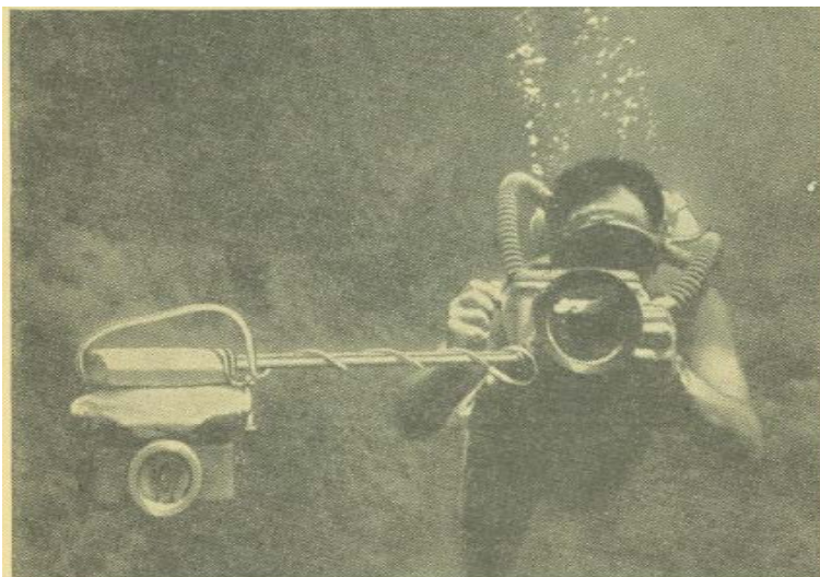
Рис. 53. Для более правильного освещения снимаемых предметов бокс с лампой-вспышкой вынесен вперед и в сторону.
