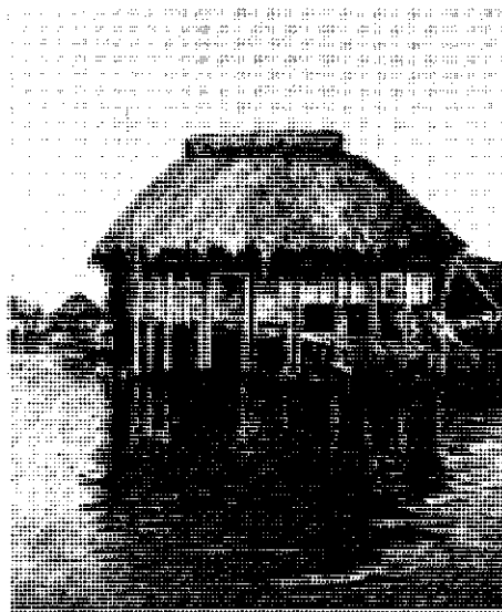
8. Свайное жилище: на квадратной платформе — хижина из жердей с конической трапеяной кровлей на круглом основании (джер). 9. Ульевидная глиняная хижина (мусгу): 1 — хижина женщины, 2 — хлев, 3 — кухня, 4 — кладовая, 5 — зернохранилище). 10. Усадьба мифу: постройки из камня на глиняном растворе, с коническими соломенными крышами (1, 6 — комнаты, 2 — зернохранилище, 3 — хлев, 4 — кухня, 5 — терраса). 11. Свайное жилище в селении Ганье в Бенине. 12. Хижина мусгу. 13. Крааль масаи. 14. Деревня в Кверуне. Вид сверху. 15. Деревня в Кверуне.
