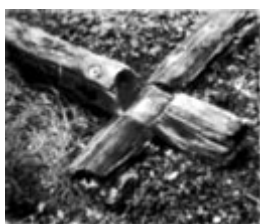
150. Способ рубки угла Южной башни
