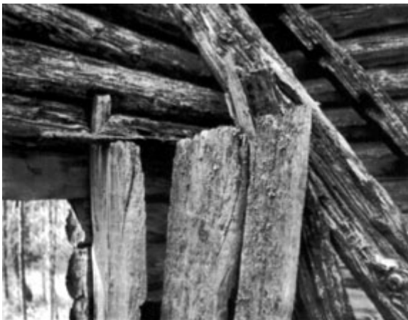
147. Конструктивное устройство двери на деревянных пятах
