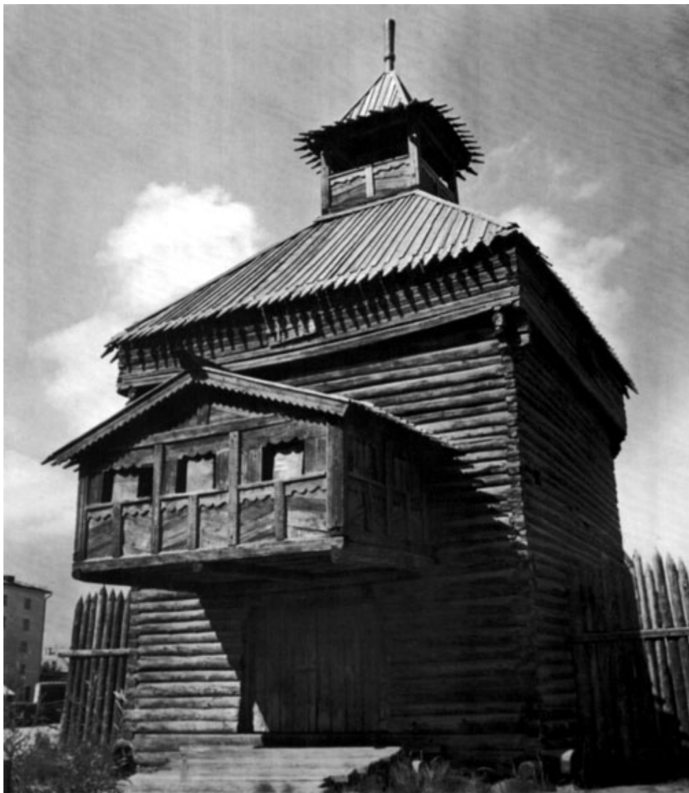
192. Западная проездная башня после реконструкции 1981 г.
