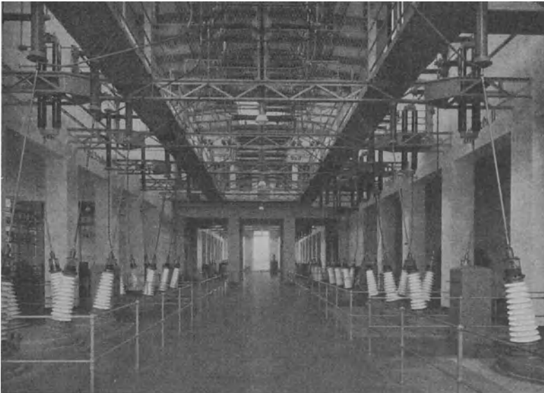
Abb. 347. Schaltheus mit zwei Reihen eingehängter Ölschalter, Reihe 100. BBC.
