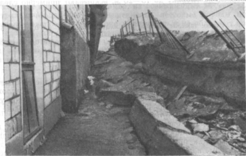
Рис. 89. Язык действующего оползня, наступающего на здание (пос. Быковец). Фото Г. Е. Костика
