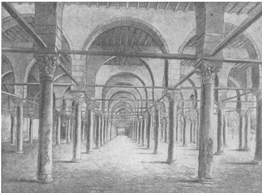
Первая построенная в Египте мечеть, носящая имя Амра ибн ал-Аса. Внутренний вид.
