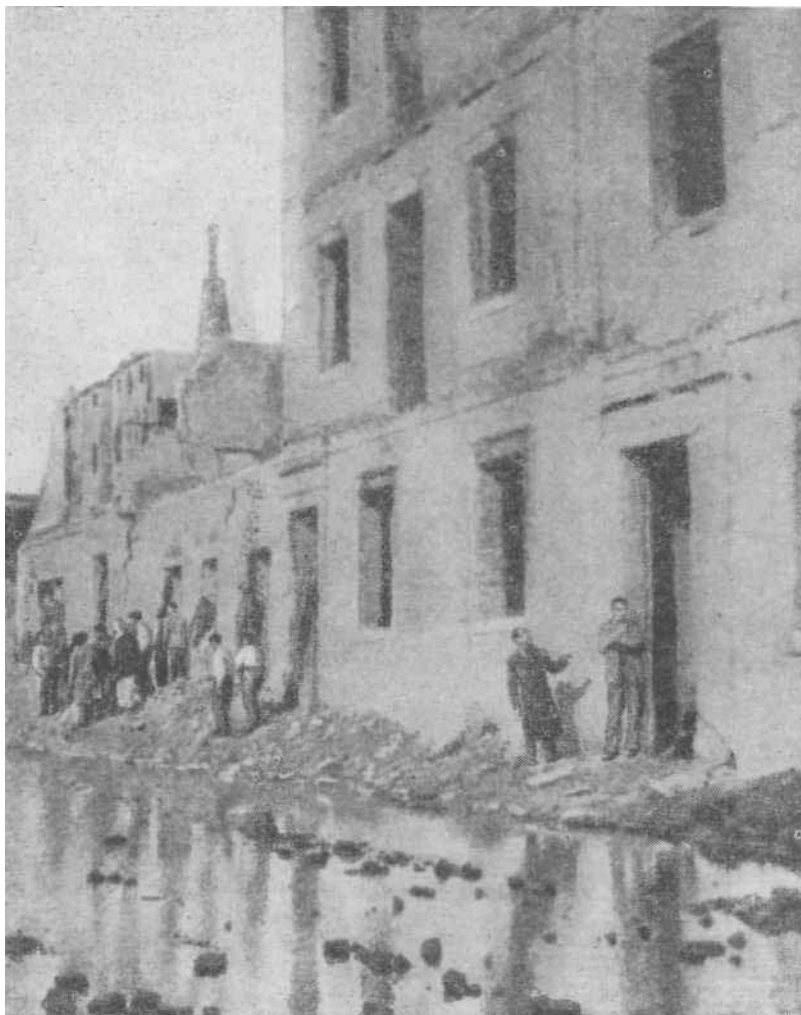
Разрушения на улице Абади в Порт-Саиде.
