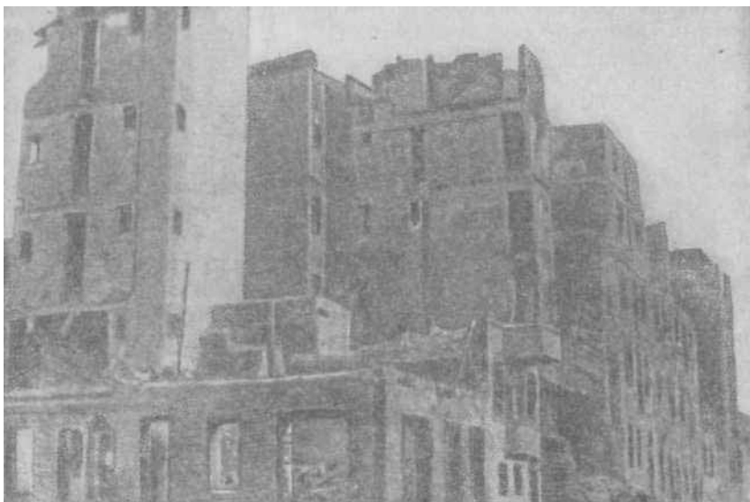
Разрушенные дома на улице Мухаммеда-Али в Порт-Саиде.
