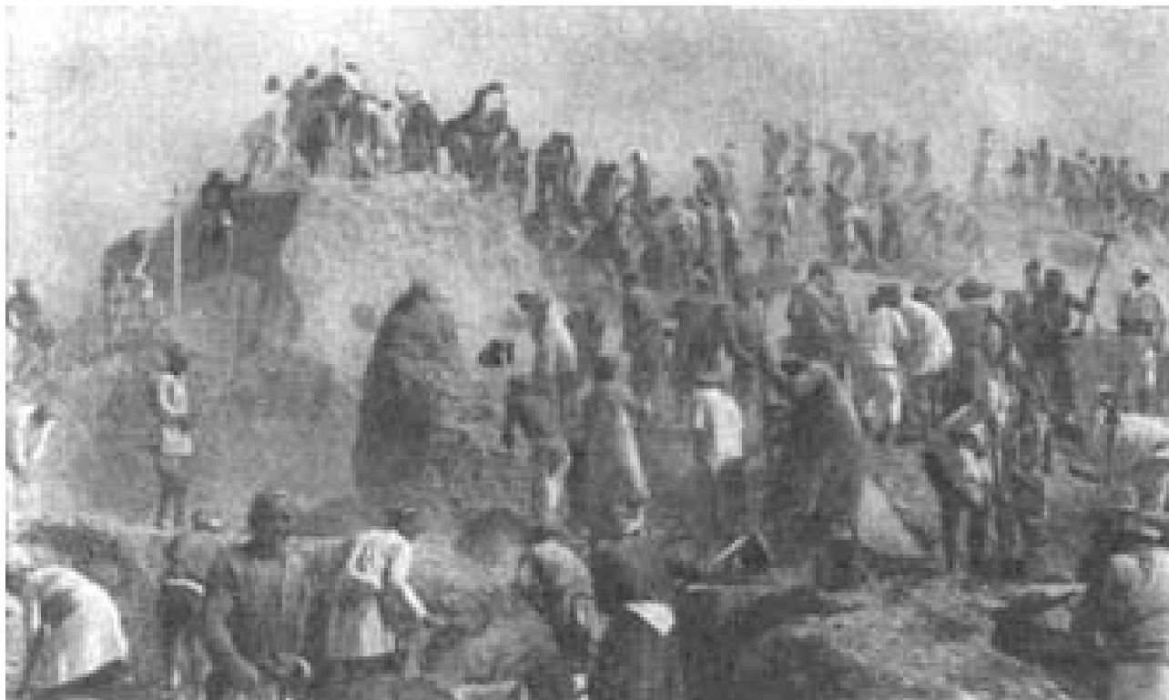
Строительство Большого Ферганского канала. Фотография. 1939 г.
