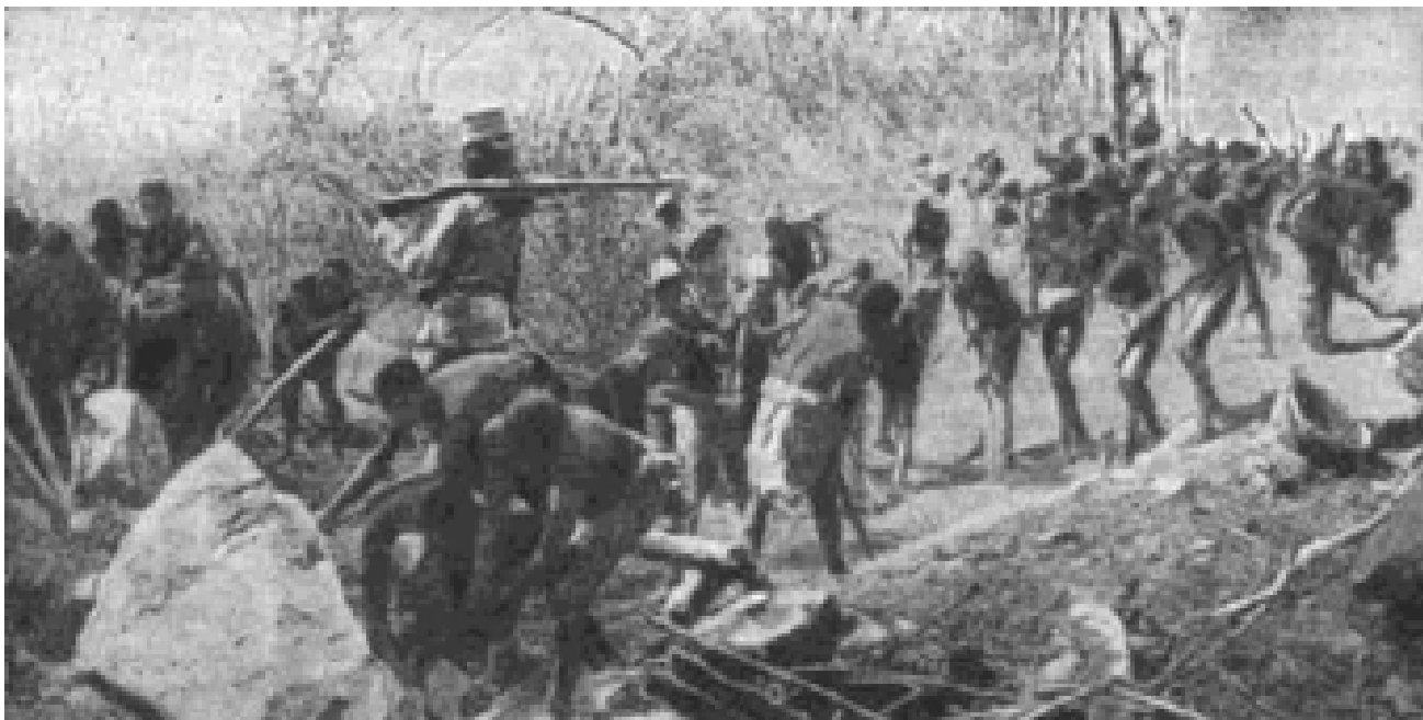
Прокладка дороги в Конго. Фотография.
