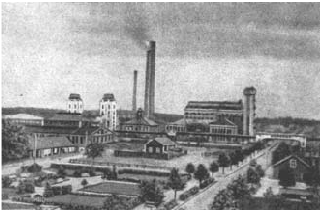
Фабрика целлюлозы в Варкинасе. Фотография. 1939 г.
