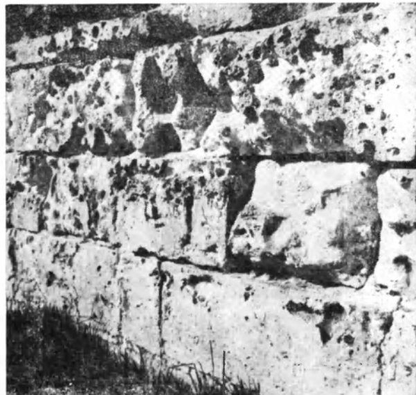
121. Смоленск. Городская стена. Разрушение кладки от расслаивания при замерзании намокшей кладки
