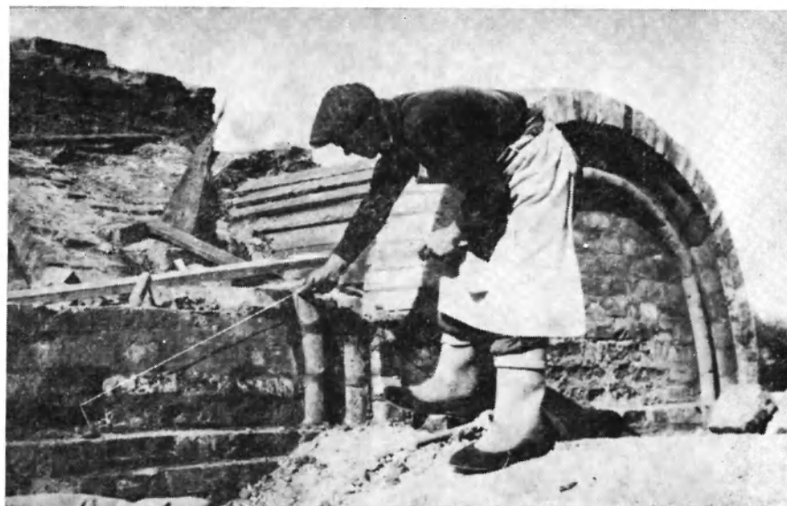
101. Москва. Церковь Никиты за Яздой. Использование отверстий в центре построения кривизны для восстановления кокошников южного портала
