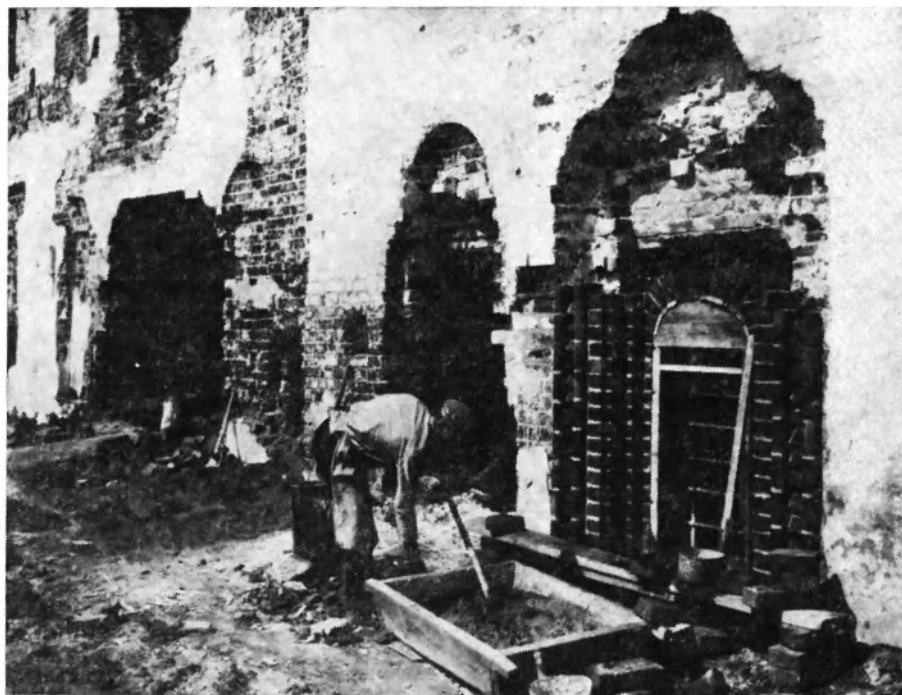
100. Ярославль. Архиерейский дом. Метод разверстки при выкладке окна
