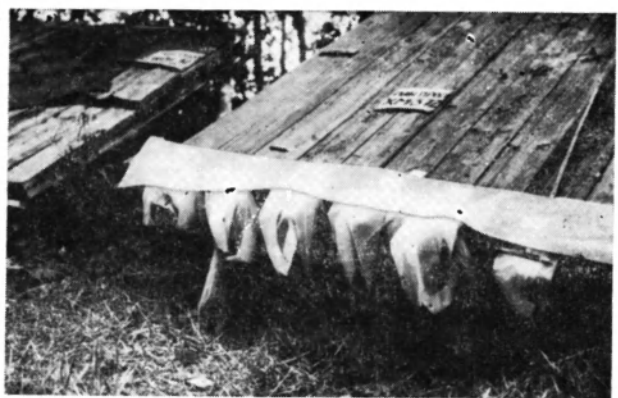
92. Кижы. Музей-заповедник. Модель на полигоне Се-нежской лаборатории. Пропитка пяток куриц способом подвесной ванны
