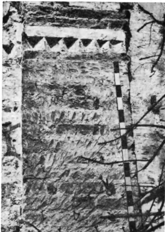
58. Москва. Церковь Николы на Студенце. Западная пилястра южного фасада в процессе раскрытия. Применение масштабной линейки
