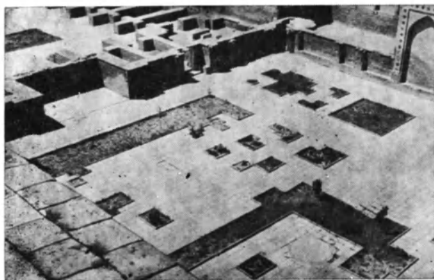
119. Самарканд. Гур-Эмир. Вымостка двора бетонными плитами
