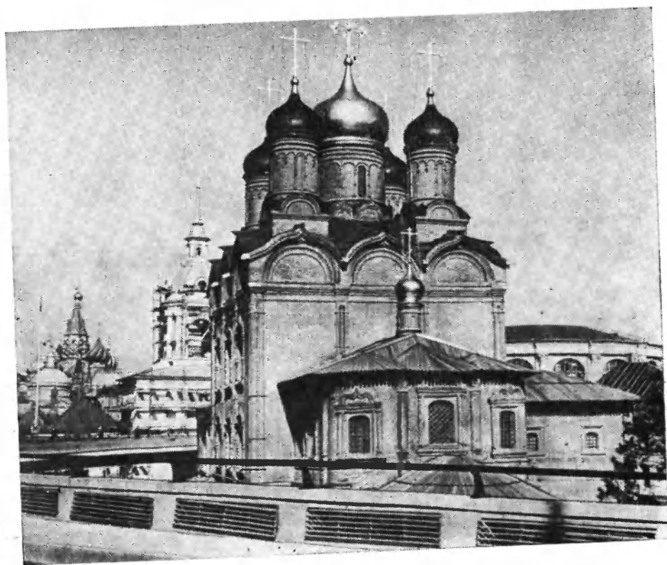
36. Москва. Знаменский монастырь. Опорная фотография. Проверка силуэта завершения методом натурального макетирования. Завершение собора после реставрации
