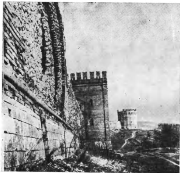
121. Смоленск. Городская стена. Разрушение кладки от расслаивания при замерзании намокшей кладки
