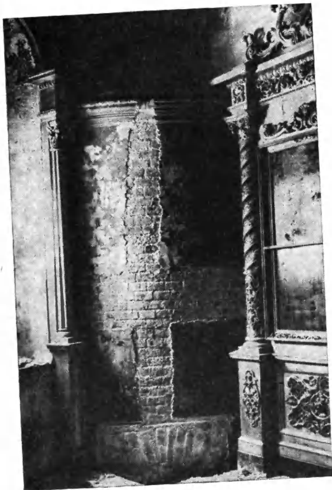
45. Москва. Церковь Покрова в Филях. Зондаж поздней докладки. Вид после удаления поздней кладки
