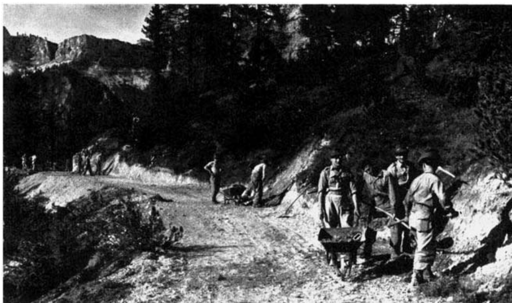
Reparti alpini costruiscono la strada di accesso alla pista dello slalom gigante sul Pian della Bigontina, che fu ultimata nell'estate 1955.
