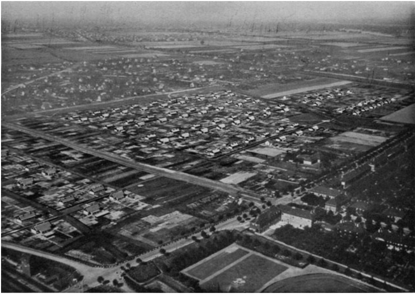
Abb. 1. Siemens-Siedlung Staaten, vom Flugzeug aus aufgenommen.
