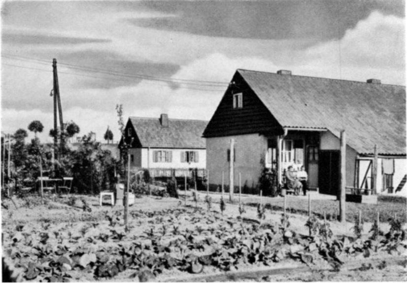
Abb. 6. Siemens-Siedlung Staaken, Vorderansicht des Hauses. Aufnahme: E. Venz, Berlin.
