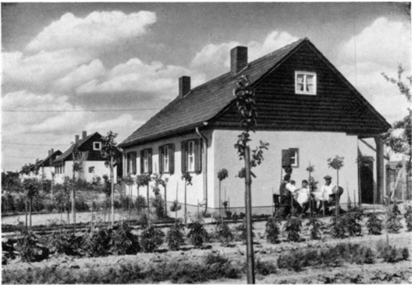
Abb. 7. Siemens-Siedlung Staaken, Rückansicht des Hauses. Aufnahme: E. Venz, Berlin.
