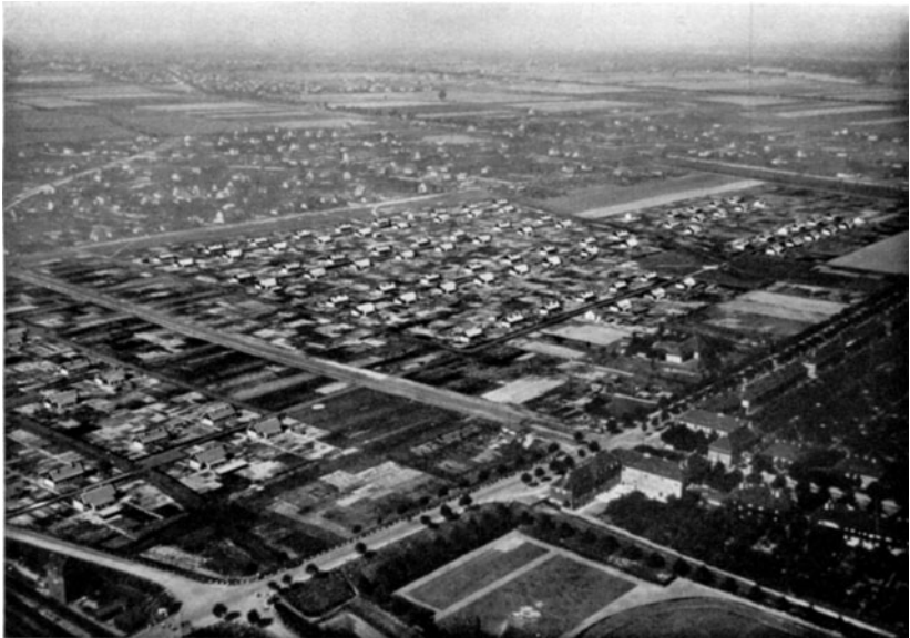
Abb. 1. Siemens-Siedlung Staaken, vom Flugzeug aus aufgenommen.
