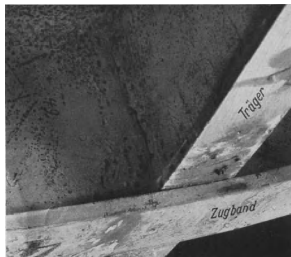
Abb. 18. Kreuzungsstelle von Träger und Zugband an der Stahlzellendecke A_3 .
