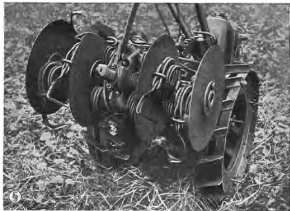
Abb. 170. Siemens-Fräse mit Schälhaken und Waldscheiben. (Aus der Sammlung des Iffa, Eberswalde.)
