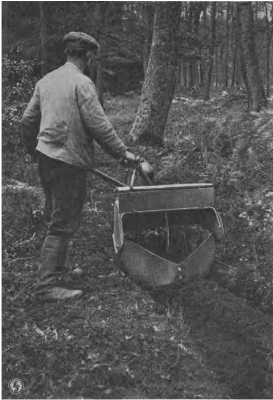
Abb. 171. Siemens-Fräse mit Häufelvorrichtung. (Aus der Sammlung des Iffa, Eberswalde.)
