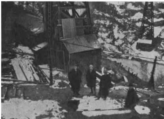
Abb. 77. Führung der Seile über Pendelstützen.
