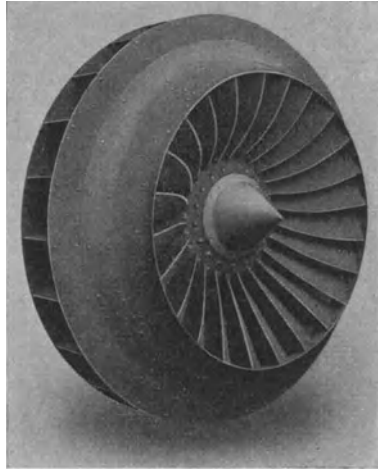
Abb. 252. Flügelrad des Pelzerventilators.
