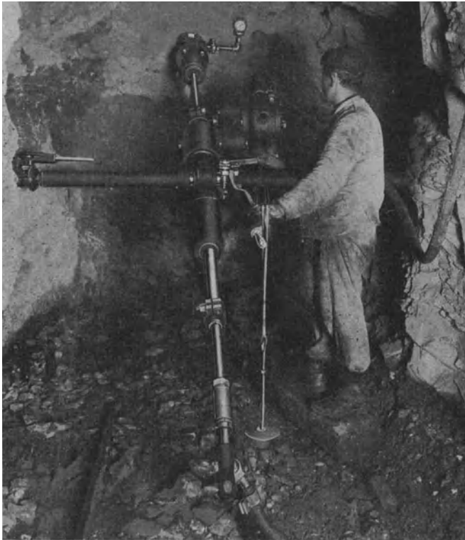
Abb. 143. Horizontalbohrmaschine an einer Spannsäule. (Alfred Wirth, Erkelenz.)
