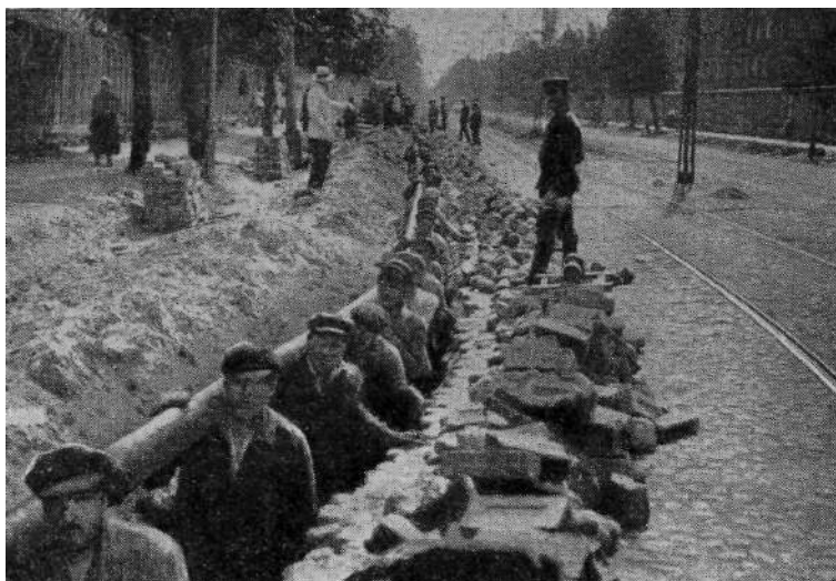
Строительство кабельного кольца напряжением 35 киловольт.
