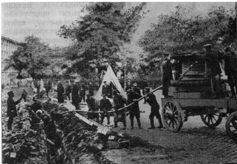
Прокладка кабеля на Дворцовой площади. Фото 1913 года.
