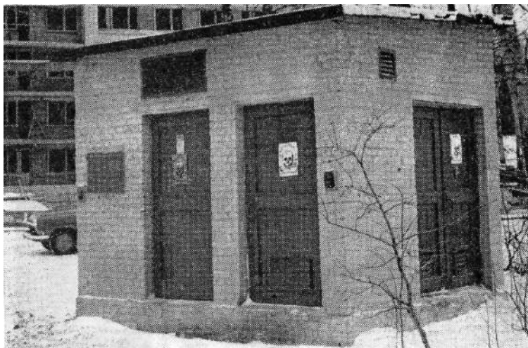
Трансформаторная подстанция 1930 года.
