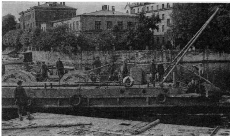
Прокладка кабельной линии с подводно-монтажного судна.
