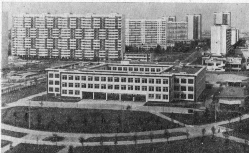
Рис. 9.3. Школа панельно-каркасной конструкции
