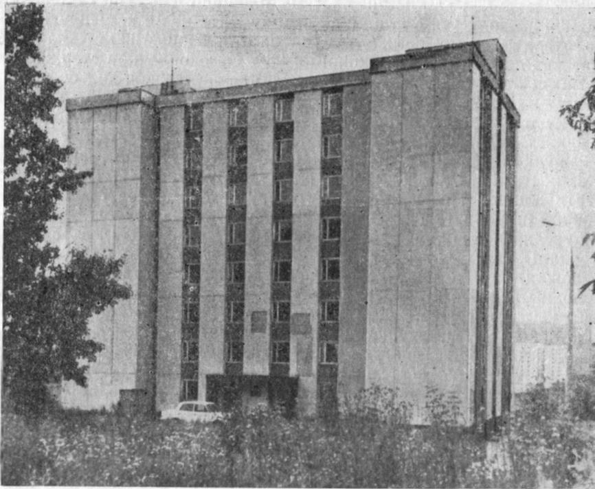
Рис. 9.5. Экспериментальное здание со «скрытым» каркасом
