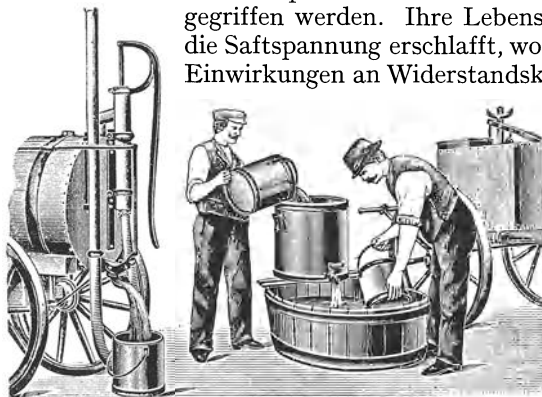
Abb. 433. Auflösungs- und Reinigungsapparat für Eisenvitriol von Drescher in Halle a. S.
