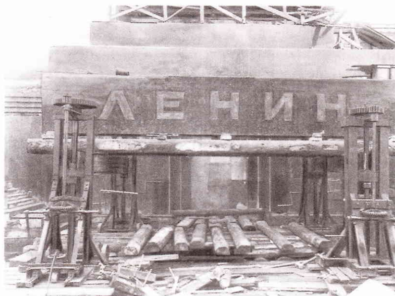
Черный блок с красными буквами ЛЕНИН подняли и установили над входом с помощью домкратов.
