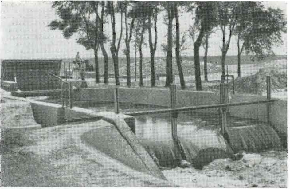
Головной регулятор распределителя Ат-Башинской оросительной системы. Чуйская долина
