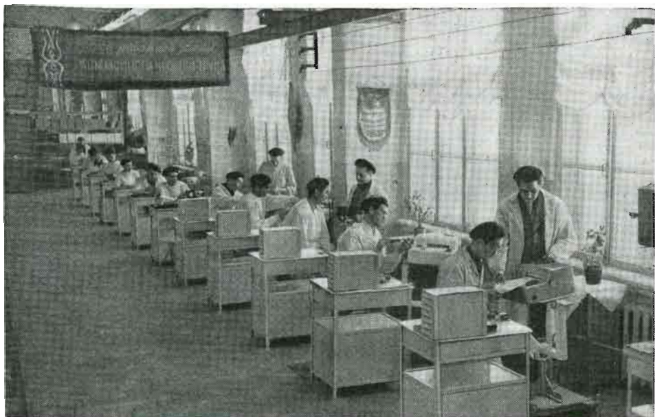
Завод физических приборов в г. Фрунзе. Сборочный цех
