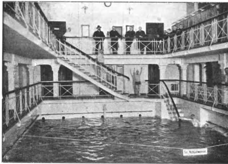
Fig. 142. Schwimmbad der Donnersmarchütte.
