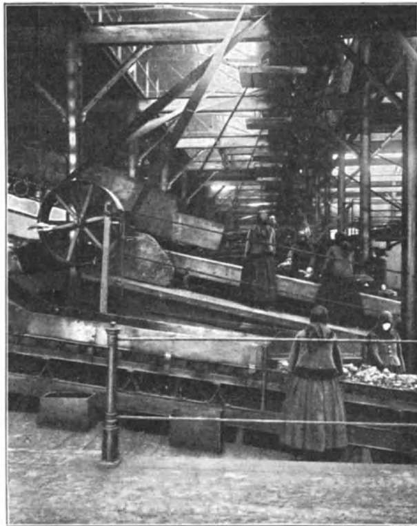
Fig. 55. Rättere auf Hedwigswunschgrube. Borsigwerk.
