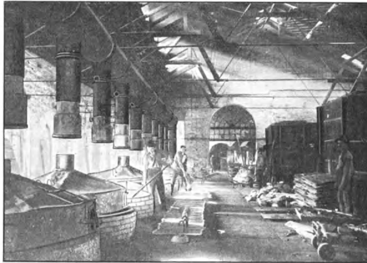
Fig. 58. Ausgießen des Bleies zu Barren.
