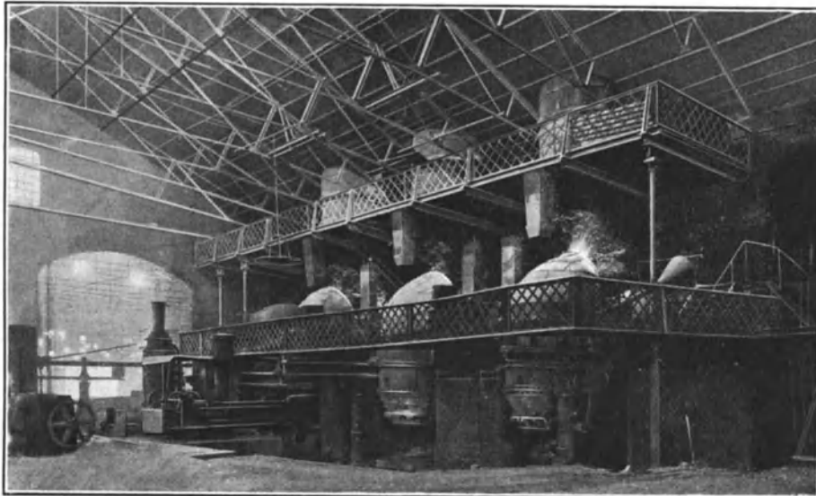
Fig. 80. Konverteranlage der Königshütte.
