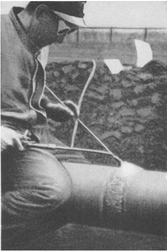
Abb. 271. Löten eines Gußrohres.
