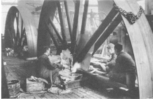
Abb. 219. Zweiteilige Walzwerks-Riemenscheibe.
