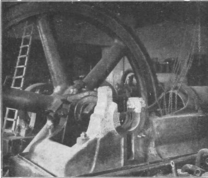
Fig. 86. Reparatur einer Maschine mittelst Thermit.
