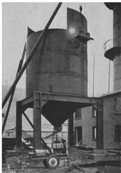
Abb. 66. Dieselschweißgenerator mit Fernregler.
