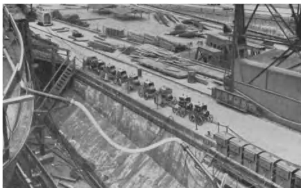
Abb. 62. Sammelkabel für mehrere Schweißstellen.
