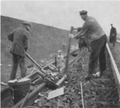
Abb. 42. Thermitschweißung, Klemmgerät.
