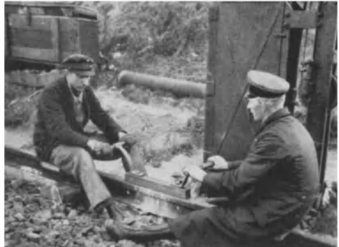
Abb. 43. Thermitschweißung, Handhobel.
