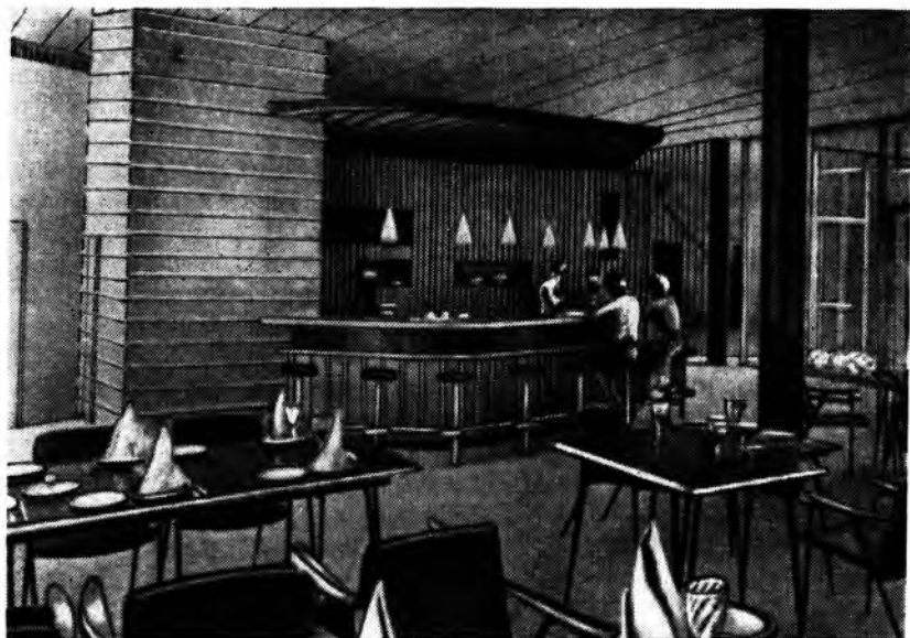
Рис. 61. Бумажнослоистые пластики в облицовке встроенного оборудования и мебели
