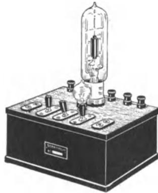
Abb. 167. Einrohrverstärker (S. & H.) mit Regelwiderstand;
