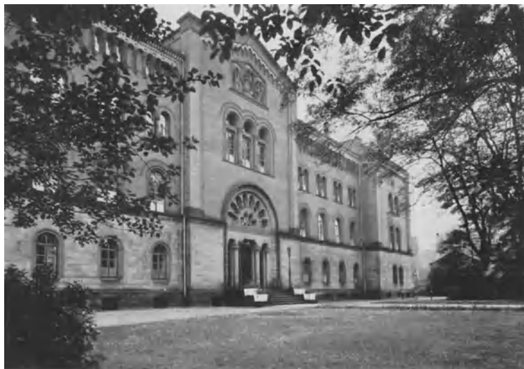
Abb. 2. Standortlazarett Hannover (Baubeginn 1842).
