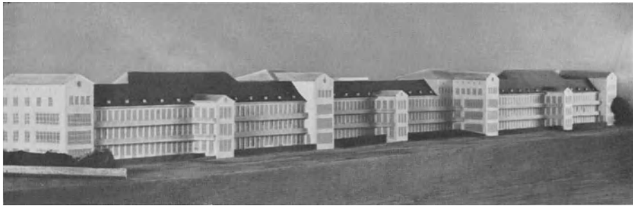
Abb. 5. Neubau Standortlazarett Hamburg (450 Betten). Entwurf: Architekt DISTEL-Hamburg.
