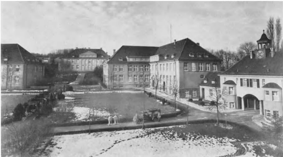
Abb. 6. Standortlazarett Ulm a/D. (Baubeginn 1913).
